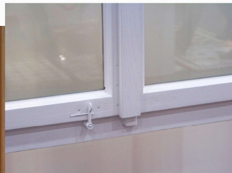
Brandschutz – Sprossenfenster in Eiche mit gasteilenden Sprossen
