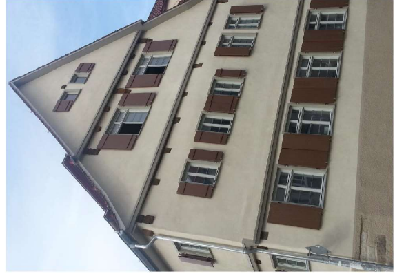
Ehningen: Verbundfenster + Futter + Klappläden
